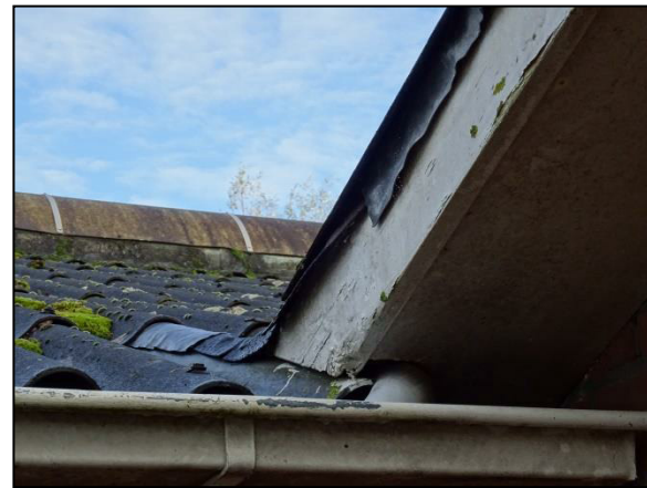
Figuur 13. Ruimte achter betimmering en loodslabben.
