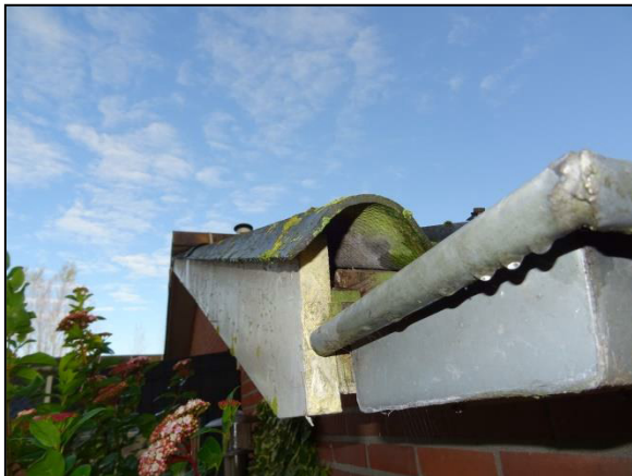
Figuur 9. Ruimte onder de dakplaten van de meest zuidelijke schuur.
