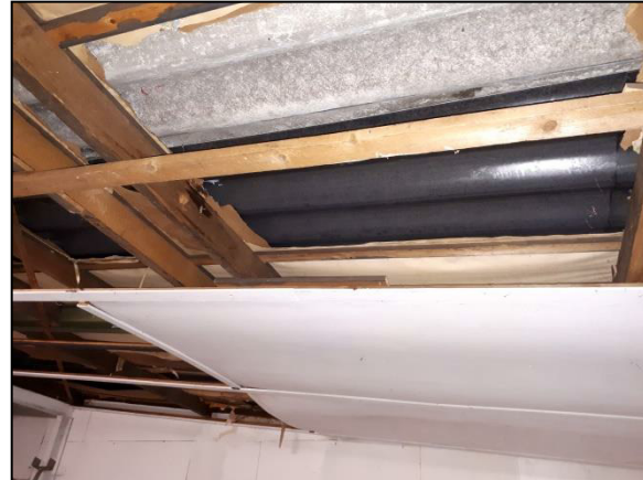
Figuur 12. Isolatie en bekleding aan de binnenzijde van de schuur.
