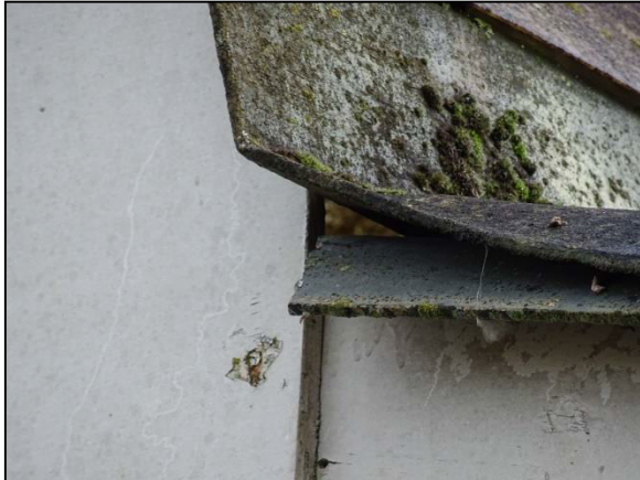
Figuur 11. Ruimte onder dakplaat bij nok van de schuur.
