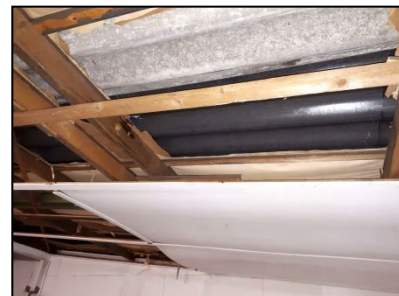
Figuur 8. Ruimte onder dakplaten aan binnenzijde schuur.
