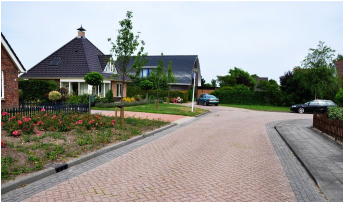
Afbeelding 11: Referentie van een klinkerstraat met gekleurde klinkers aan de zijkant om de straat optisch te versmallen
