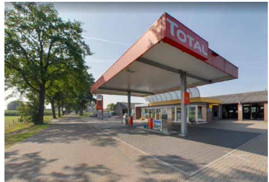
3. Tankgedeelte Vossersteeg 99 zal worden gesaneerd en gesloopt en er zal sprake zijn van landschappelijke kwaliteitsverbetering.
