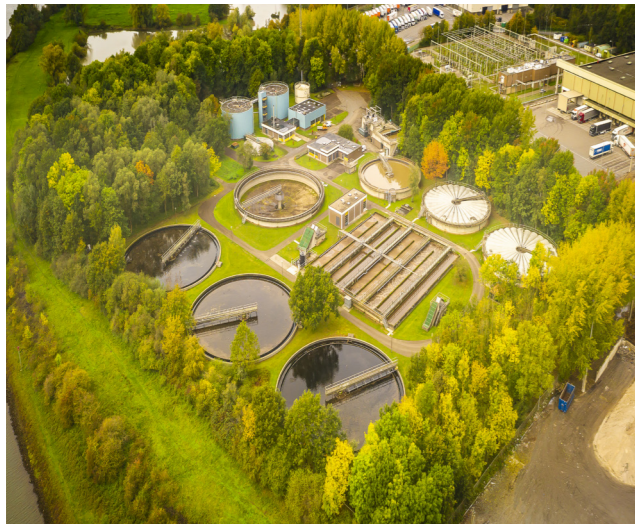
Een rioolwaterzuivering is als energievrager geschikt als locatie voor energieopwek
