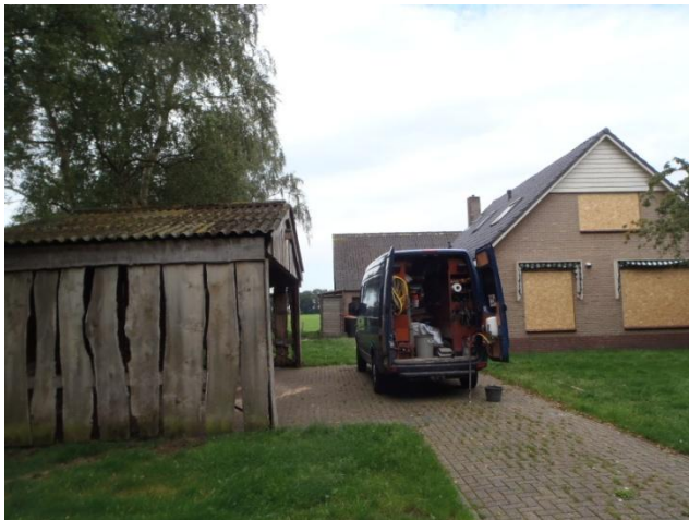
Foto 1 schuur met asbestdak
