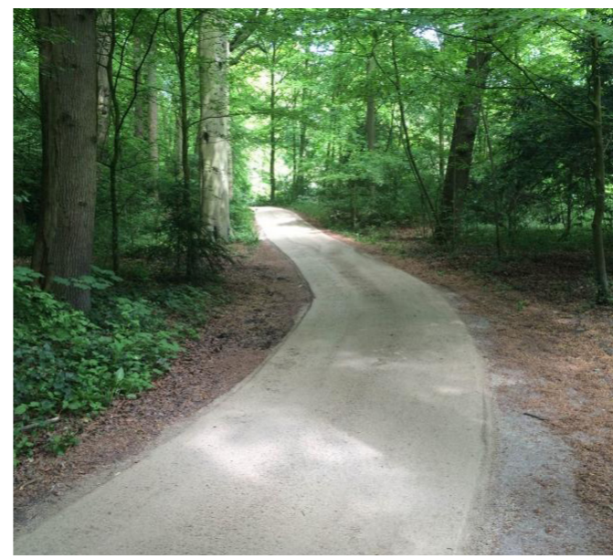
Halfverhard pad nobre cal van maximaal 3 meter als ontsluiting van de (recreatie-) woningen
