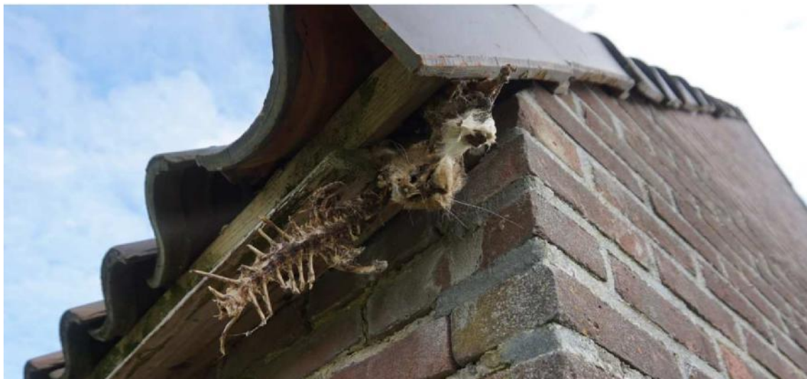
Foto 5.1. Overblijfsel van een prooi van de steenmarter aan de dakrand.
