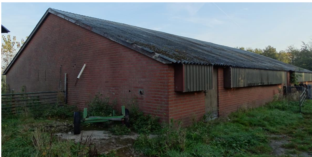
Figuur 2.3. Voormalige varkensschuur, wordt geheel gesloopt (ondervloer bevat asbest), gebouw 4 op figuur 2.2.
