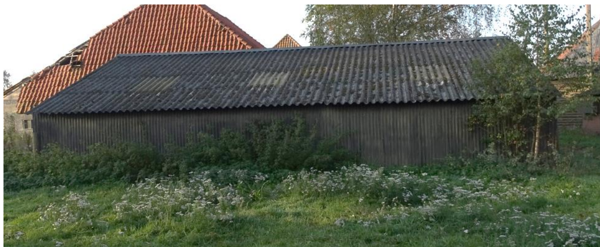
Figuur 2.4. Schuur die geheel gesloopt gaat worden, gebouw 3 op figuur 2.2.
