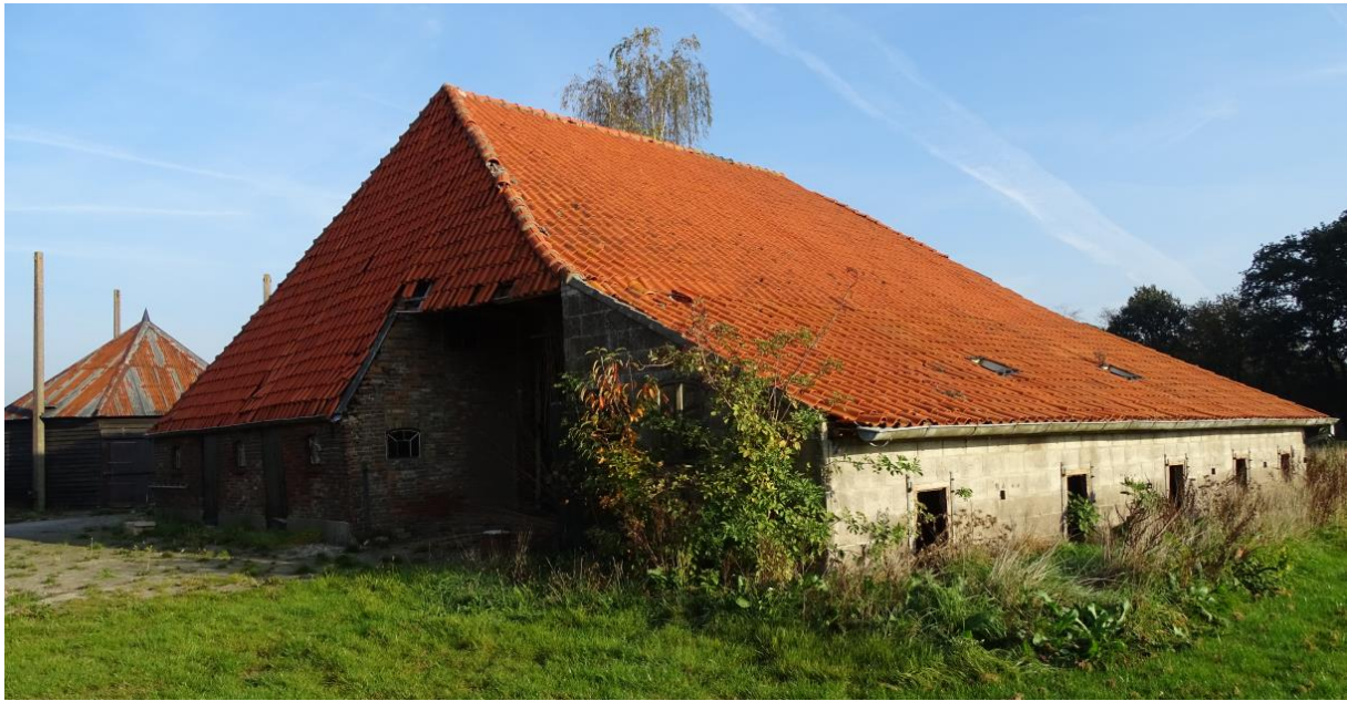
Figuur 2.6. Voorzijde van de schuur waarvan het lage gedeelte wordt gesloopt, gebouw 2 op figuur 2.2.
