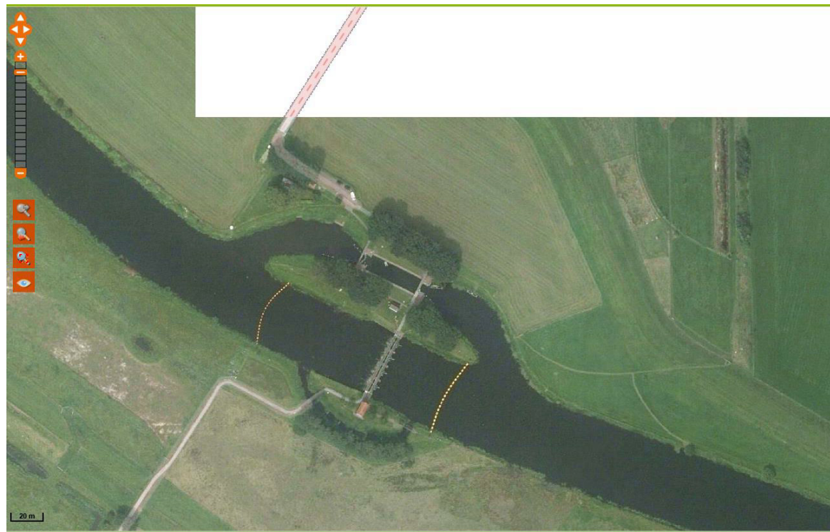
Plangebied met inrichtingswerkzaamheden.
