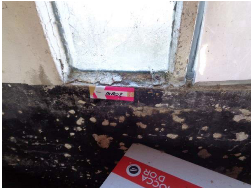
Monsternamelocatie MA03 (asbest niet aantoonbaar)
