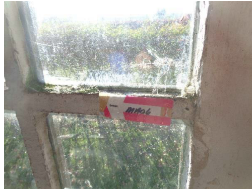
Monsternamelocatie MA04 (asbest niet aantoonbaar)
