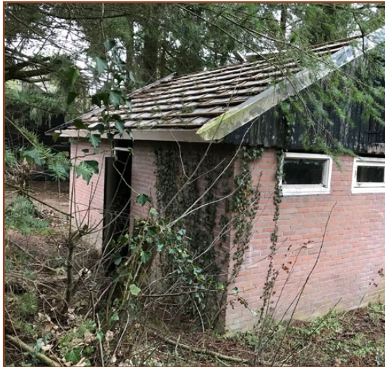
Afb. 3.4: Sanitaire voorzieningen (nr. 17). Het gebouw is niet geschikt voor vleermuizen. Echter wel voor marterachtigen en Huismus .
