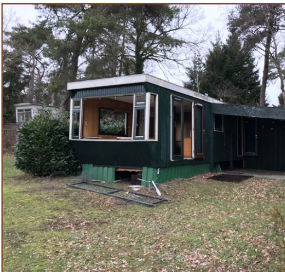
Afb. 3.6: Stacaravan nr 19. Ook dit gebouw is voor vleermuizen ongeschikt, maar geschikt voor marterachtigen en Huismus .
