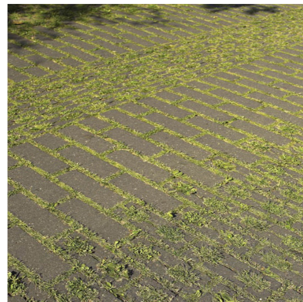
Hoogwaardige grasbetonkeien langs rijstroken en op de parkeerplaatsen bij woningen
