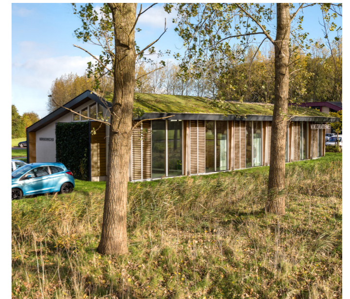
Duurzame dakbedekking als sedum-/ grasdaken dragen bij aan het natuurlijke karakter van de omgeving
