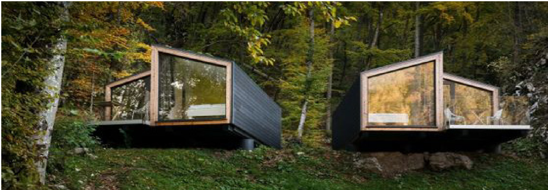
Eenvoud in opzet met richting de Vecht georiënteerde glaspuien, natuurlijk gematerialiseerd en fijn van korrel door te spelen met de positie van de volumes en het dakvlak
