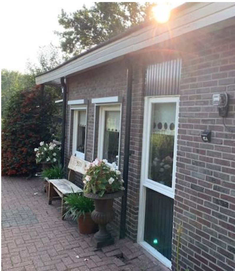
Afbeeldingen 2 en 3: Actuele situatie t.p.v. het woonhuis De Stuw 8 te Dalfsen.
