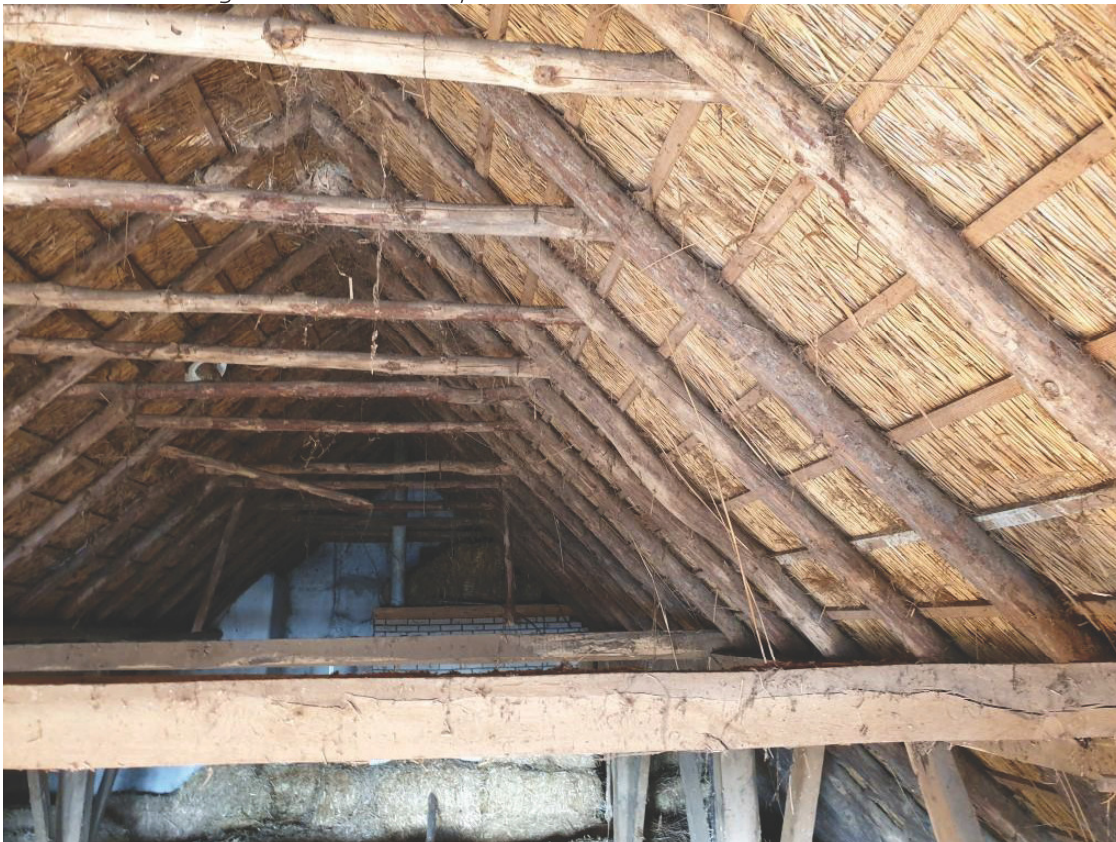
Overzicht van de gebintconstructie op zoldervloerniveau
