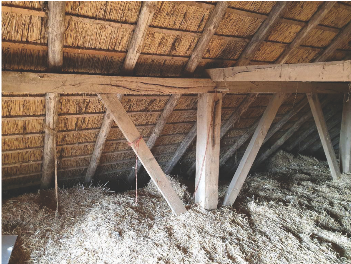
Overzicht van de gebintconstructie op zoldervloerniveau – constructie wordt gehandhaafd
