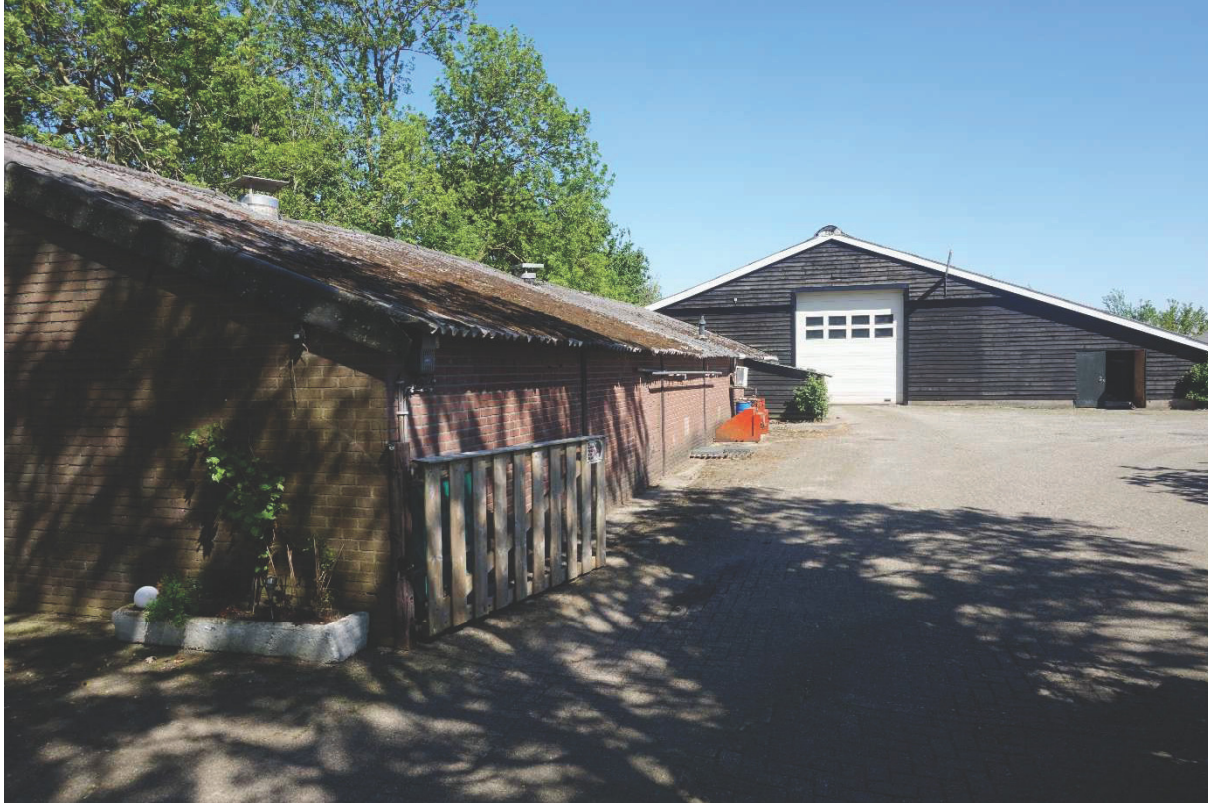
Figuur 2.2. Overzicht locatie met op voorgrond berging en op achtergrond voormalige ligboxenstal (caravanstalling).
