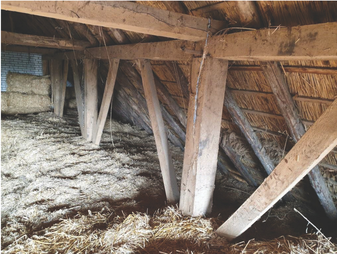
Overzicht van de gebintconstructie op zoldervloerniveau
