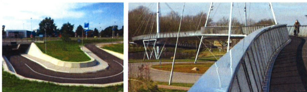
Figuur 14; Voorbeelden tunnel (links) en brug (rechts)
