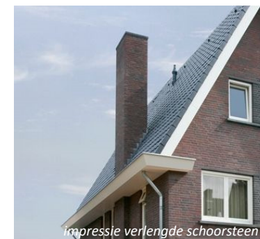
impressie verlengde schoorsteen
