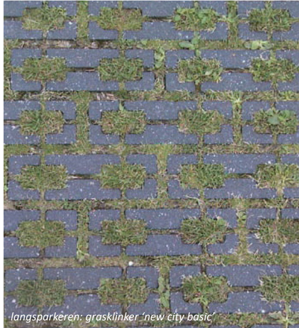
materiaal en kleurstelling bestrating: gebakken klinker DF
