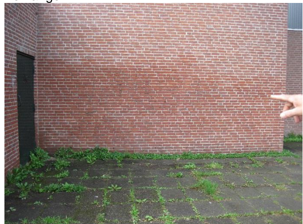
Oppervlakkige beschadigingen door reinigen
