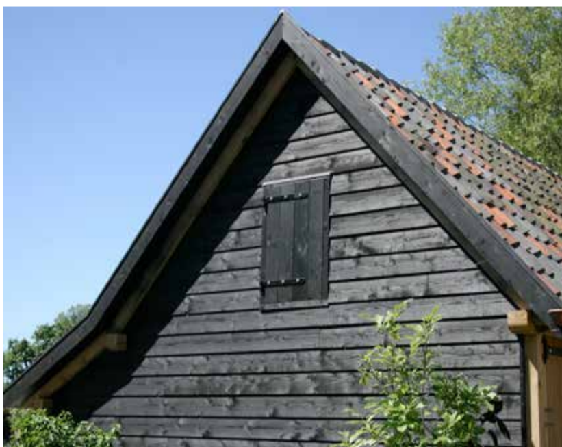
bijgebouw als kapschuur (nieuw of behouden) en beklede met potdekselwerk
