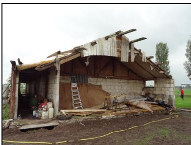
Figuur 6. Aanzicht stal, gezien vanaf het zuidoosten.
