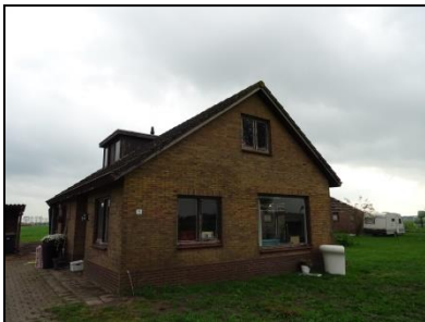
Figuur 3. Aanzicht woning, gezien vanaf het zuiden.
