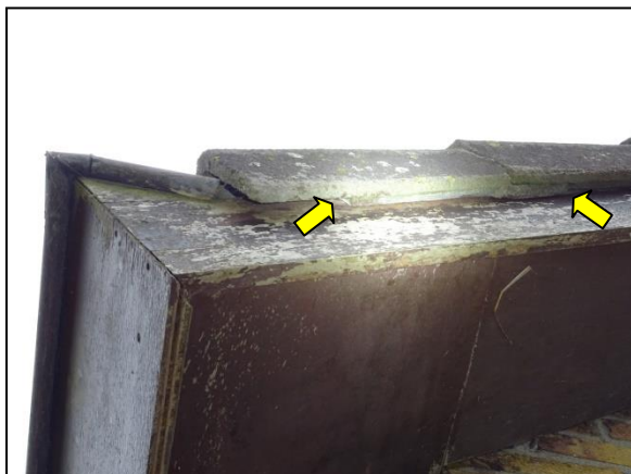
Figuur 9. Detailfoto van boeiboord, windveer en kantpannen. De ruimte tussen het dakbeschot/windveer en dakpannen is opgevuld met kunststof materiaal (zie gele pijlen).
