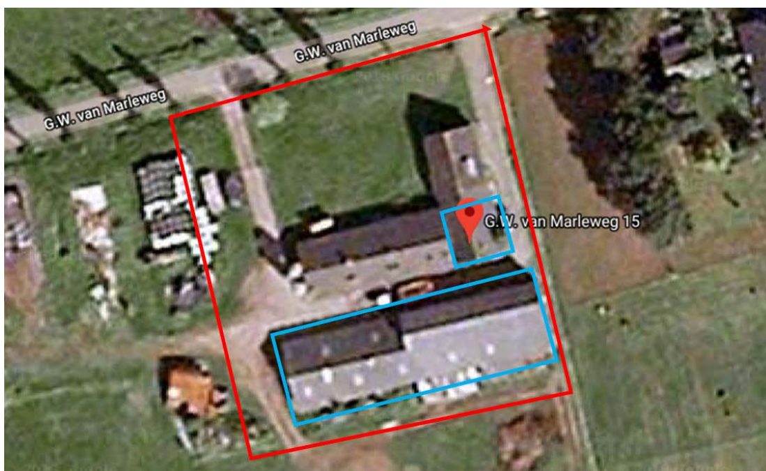
Figuur 2.1: onderzoekslocatie (rood) en de recent gesloopte bebouwing (blauw)
