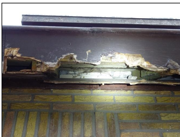
Figuur 11. Detailfoto boeiboord met gaten, wat leidt tot een ongunstig microklimaat voor vleermuizen.
