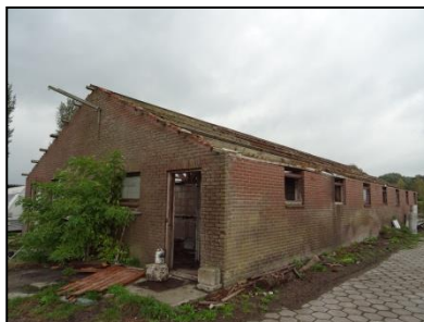
Figuur 7. Aanzicht stal, gezien vanaf het zuidwesten.
