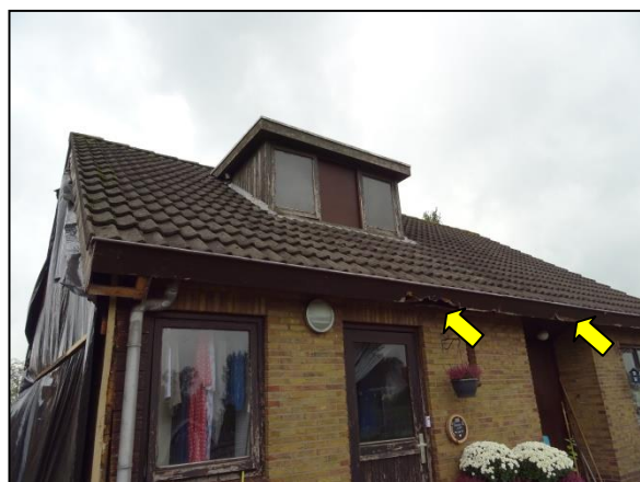
Figuur 12. Overzichtsfoto boeiboord met gaten (zie gele pijlen).
