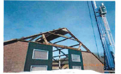
foto 9: Golflaten van zoppeval voormalige stal verwijderd
