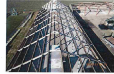
foto 3: Golflaten van dak voormalige stal verwijderd
