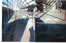
foto 7: Vloer in voormalige stal / foto 8: Vloer in kapschuur
