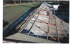
foto 4: Golflaten van dak kapschuur verwijderd
