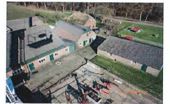
foto 6: Kleine stal, stal met aanbouw koelkast en paardenstal blijven nog voorzetten van golflaten
