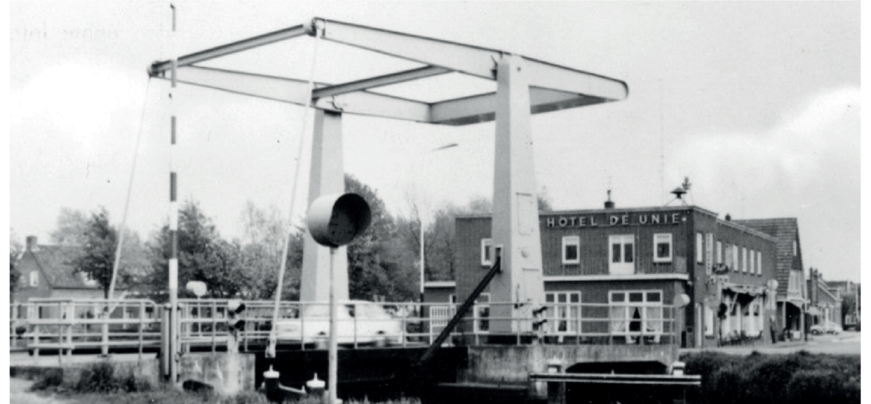
Brug over het voormalig kanaal
