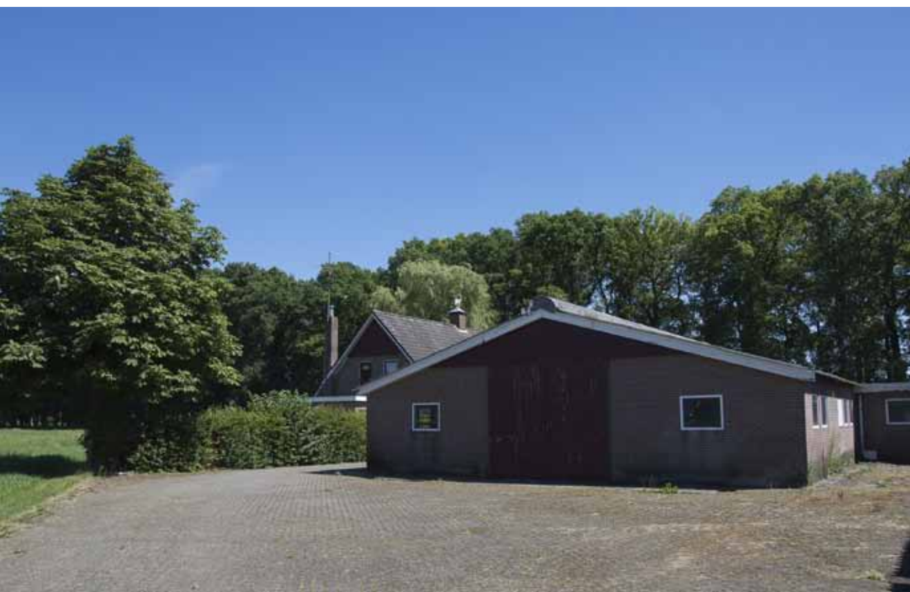
Afbeelding 22. Projectlocatie: achteraanzicht paardenstal
