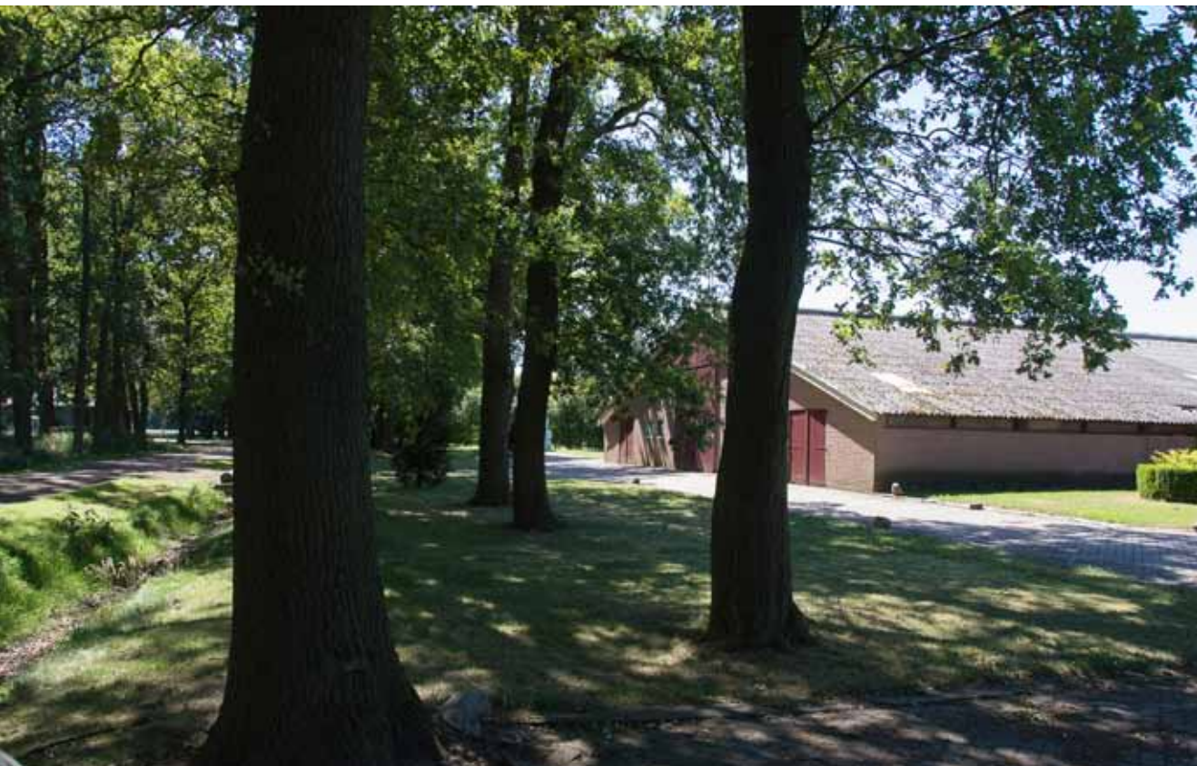
Afbeelding 19. Projectlocatie: te slopen schuur
