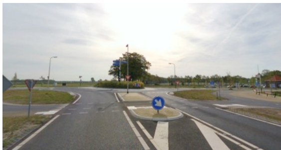
Realisatie rotonde Poppenallee bij station
