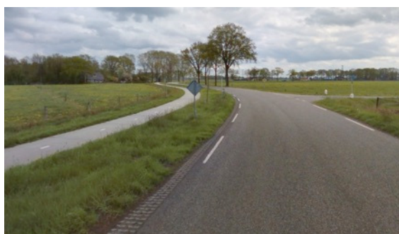
Realisatie fietspad Dommelerdijk (bocht)
