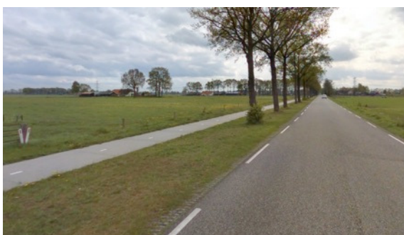
Realisatie fietspad Dommelerdijk
