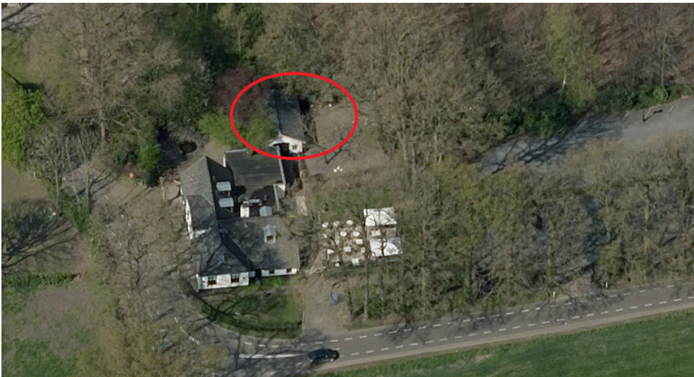
Luchtfoto Heinoseweg 30 – uitbreiding restaurant aan achterzijde (in rood)
