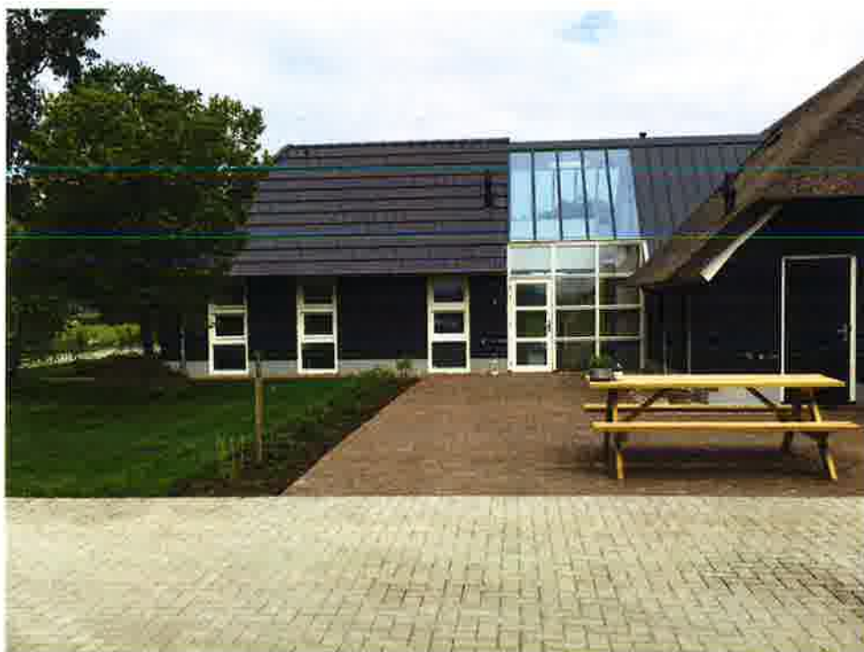
Voorbeeld van combinatie van oud en nieuw in een informele, landelijke sfeer (Dalfsen)
