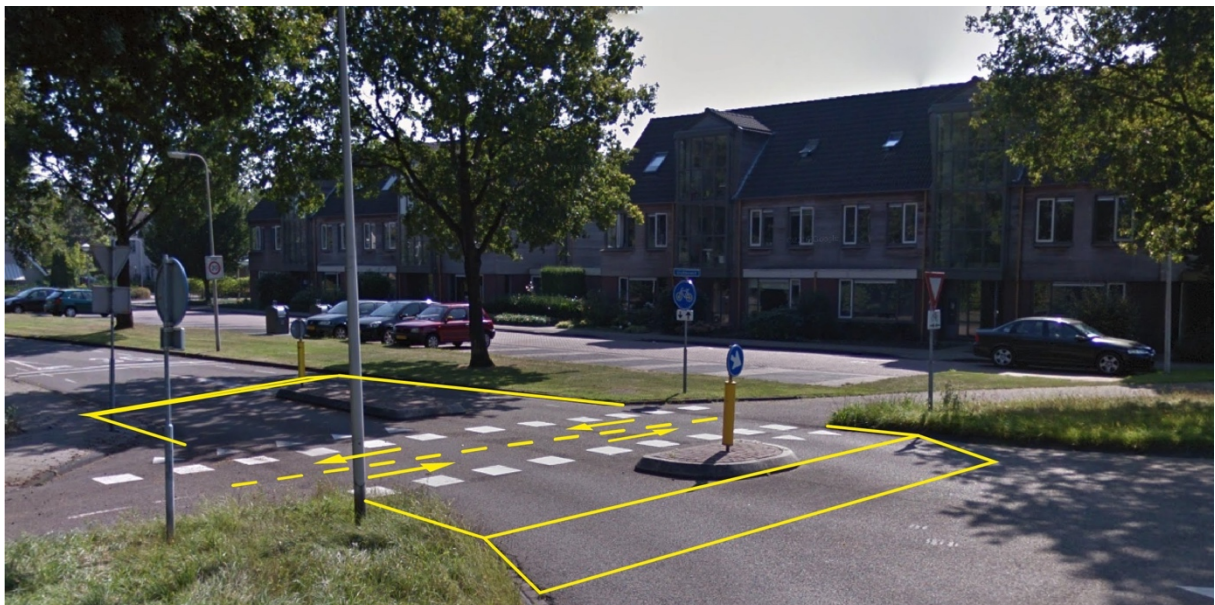
Afbeelding B2.3: Verduidelijken tweerichtingsfietspad bij kruispunt Grutterserf door markering, het doortrekken van het rode asfalt en een plateau, Dalfsen
