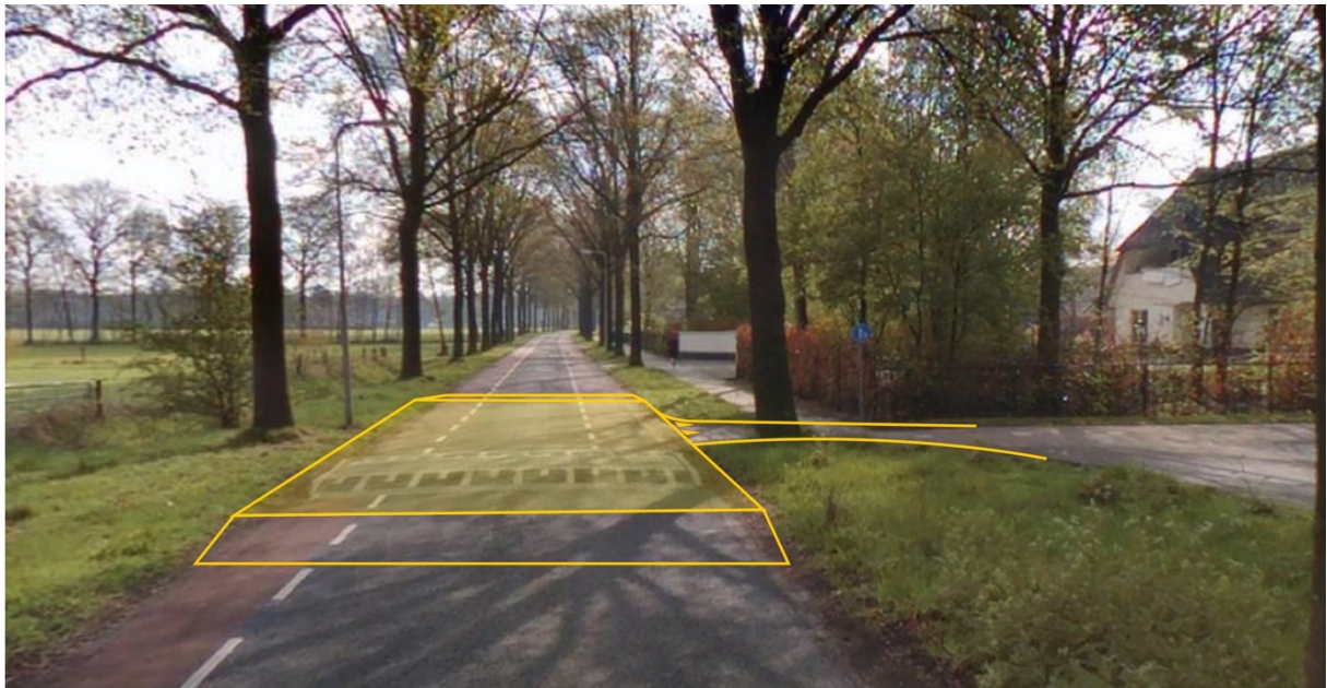
Afbeelding B2.2: Advies voor aansluiting tweerichtingsfietspad, Dalfsen
