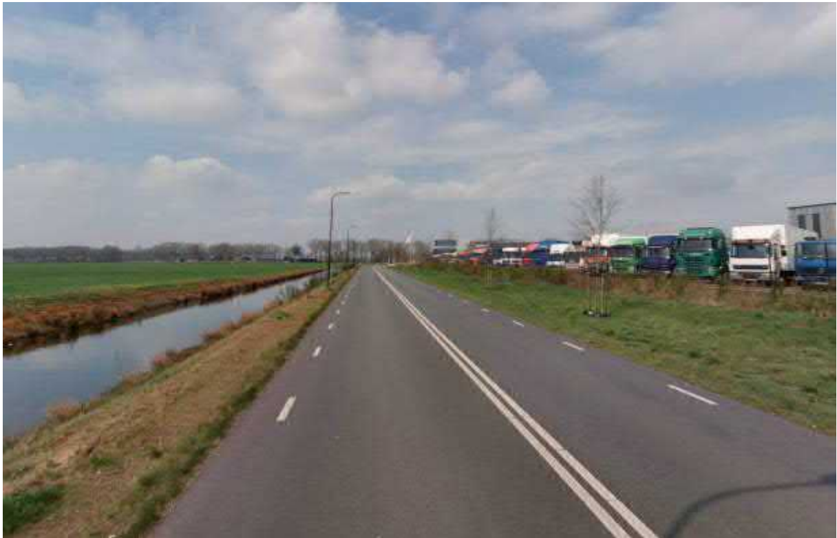
Figuur 2.5: Handelsweg. (bron: Cyclomedia)
