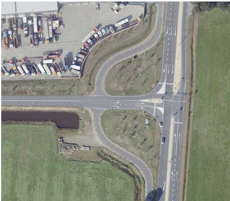
Figuur 2.4: De huidige kruising Handelsweg-N348. (bron: Cyclomedia)
