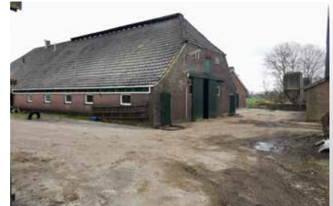
Figuur 14 Achterzijde woonboerderij, zuidkant.
