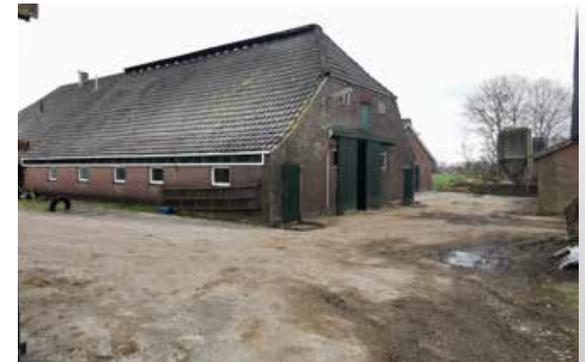
Figuur 14 Achterzijde woonboerderij, zuidkant.
