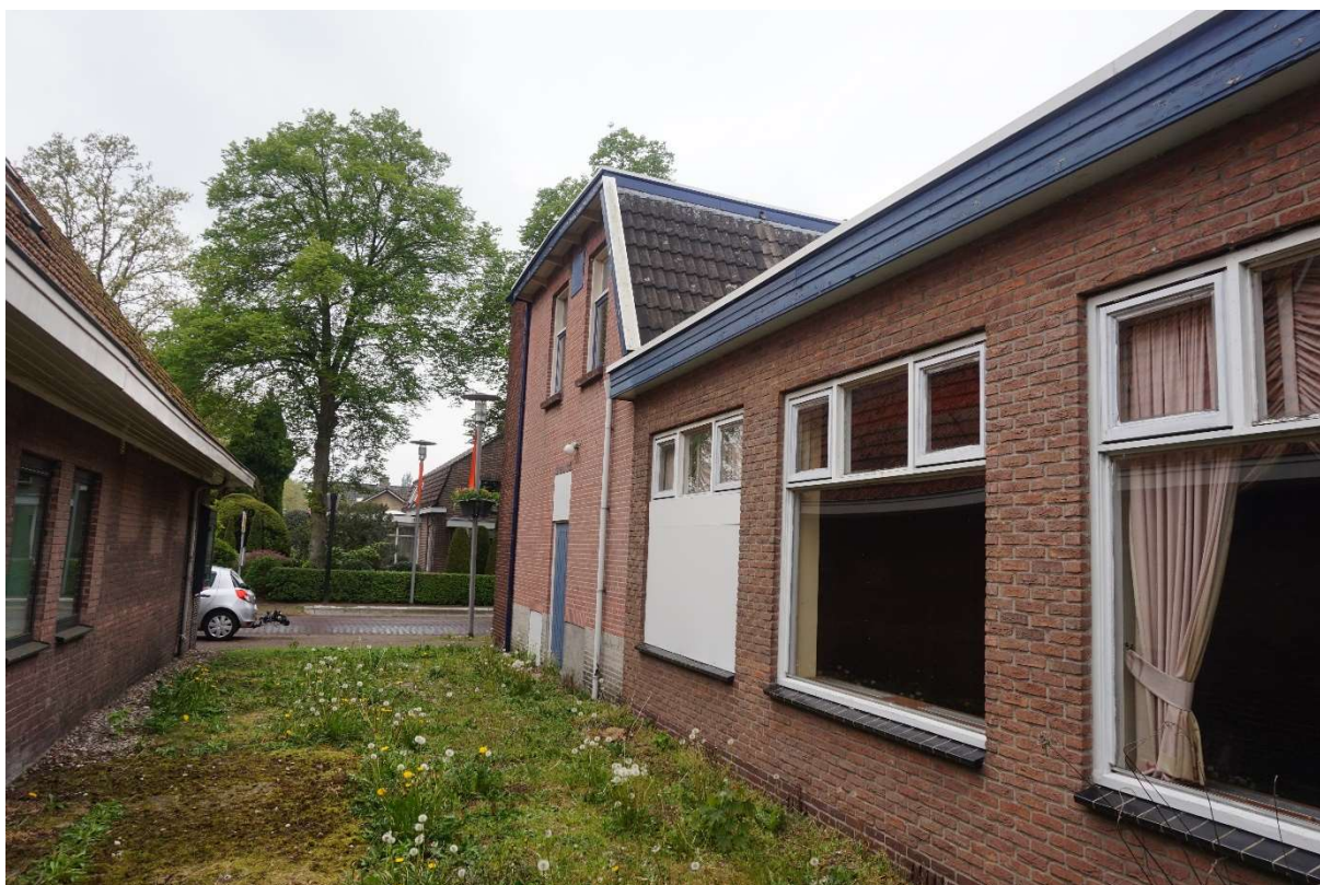
Figuur 2.5. Zuidzijde onderzoekslocatie.
